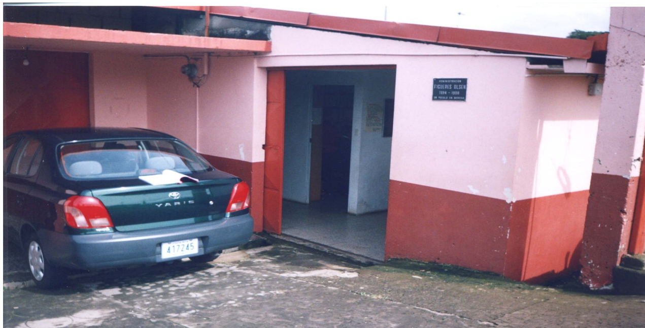
Sede I EBAIS San Josecito, San Isidro de Heredia. Estacionamiento, accesibilidad y material del piso no cumplen con la Ley 7600.
