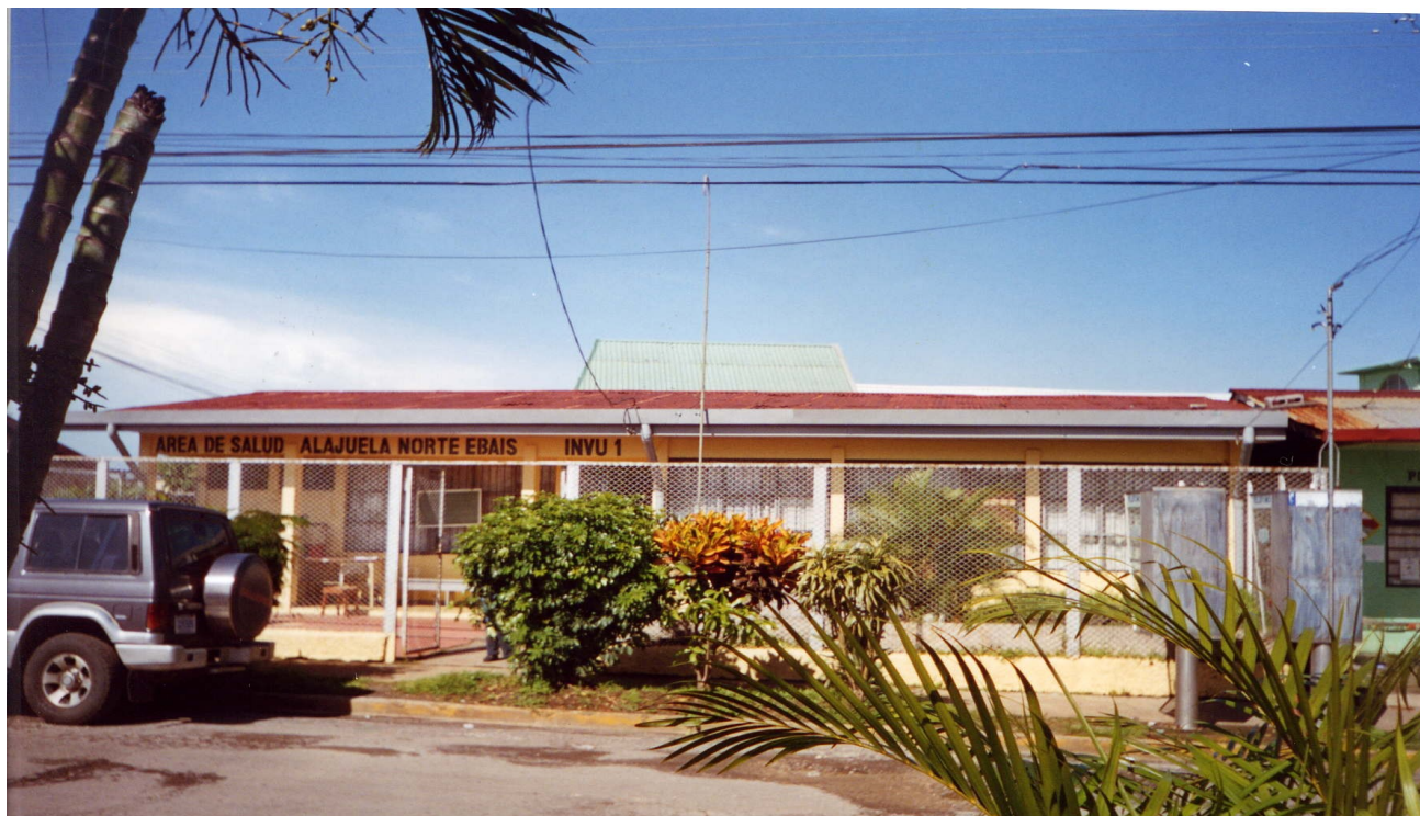
Sede I EBAIS INVU I, Las Cañas, Alajuela. Inmueble propiedad de la comunidad.
