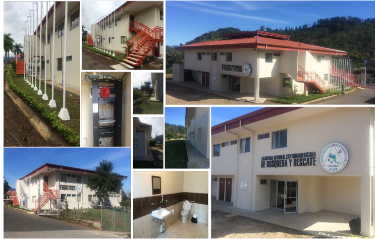
Figura 9 Obra de hospedaje y algunos de los enseres.
